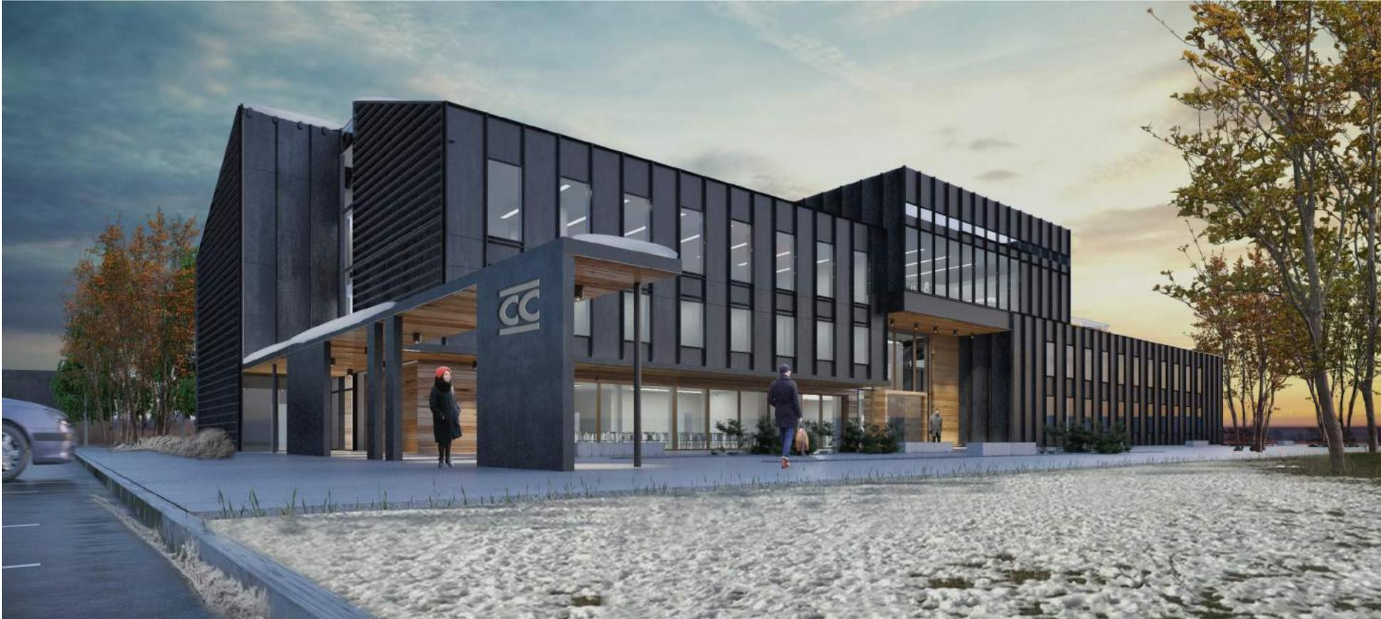
Particolare attenzione è stata posta nel rispondere alle caratteristiche climatiche estreme con inverni freddissimi ed estati estremamente calde. L'edificio risulta il più possibile chiuso e compatto riducendo al minimo le pareti vetrate. L'esterno è caratterizzato dalla **lamiera antracite che richiama il materiale che viene estratto nella miniera, contrastata tramite l'uso del larice siberiano tipico delle zone limitrofe.**
