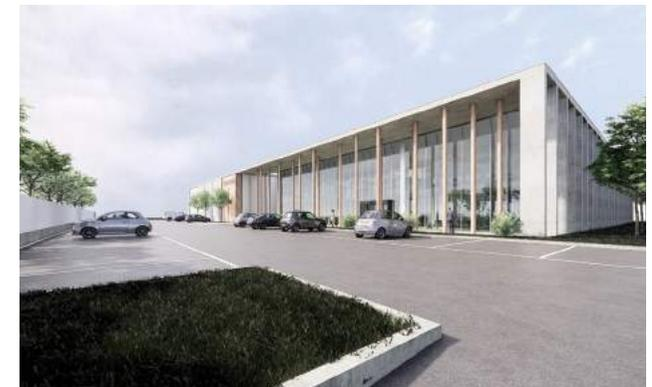
Le pilastrature molto profonde hanno la funzione di ombreggiare le vetrate e dettano **il ritmo di tutto l'edificio, stabilendo gli allineamenti e i passi strutturali.**
